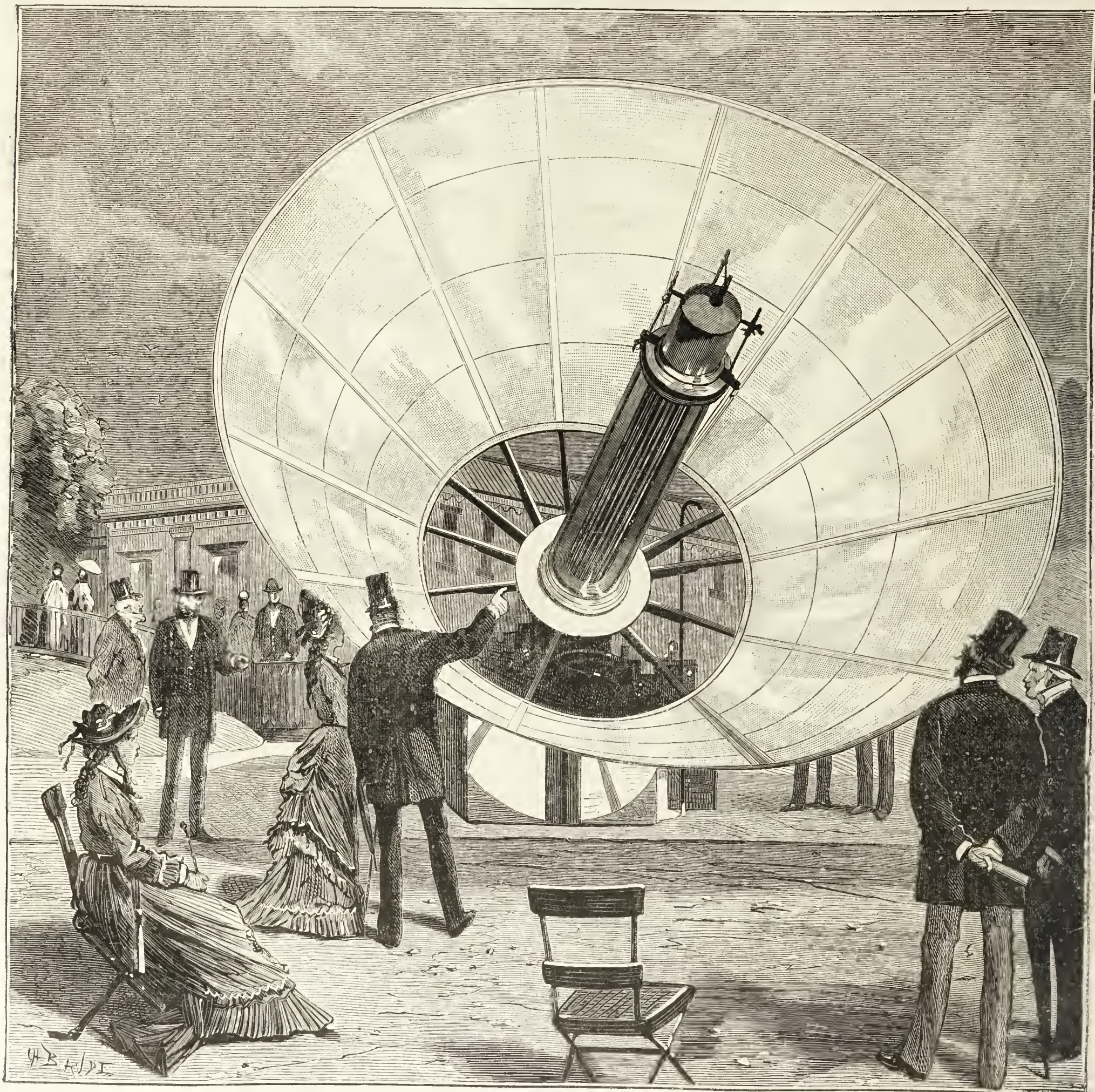
APPARECCHIO MOUCHOT PER L'UTILIZZAZIONE INDUSTRIALE DEL CALORICO SOLARE: ESPERIENZE SUL TROCADERO.
